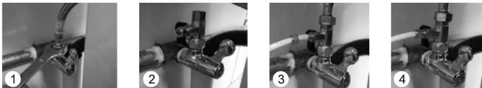
5. Установите головку фильтра, как показано на рисунке ниже, стрелка обозначает направление воды, вставьте полиэтиленовую трубку в быстросъемный фитинг головки фильтра.
